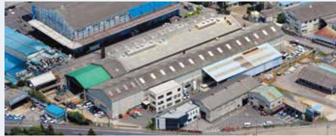
北関東工場(野田) Kita-Kanto Works (Noda) 敷地：9,920㎡ Site area: 9,920㎡ 建物：6,187㎡ Building: 6,187㎡
